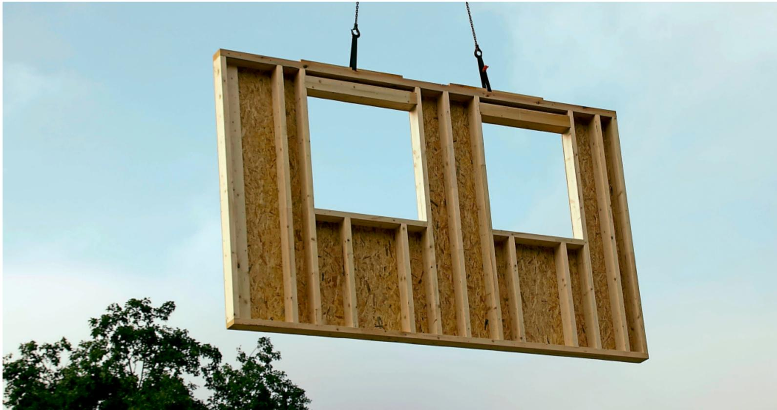
So sieht eine Fertighauswand aus, bevor die Felder mit Dämmstoff gefüllt werden und die Innenseite mit Holz oder Gipskarton verkleidet wird.
